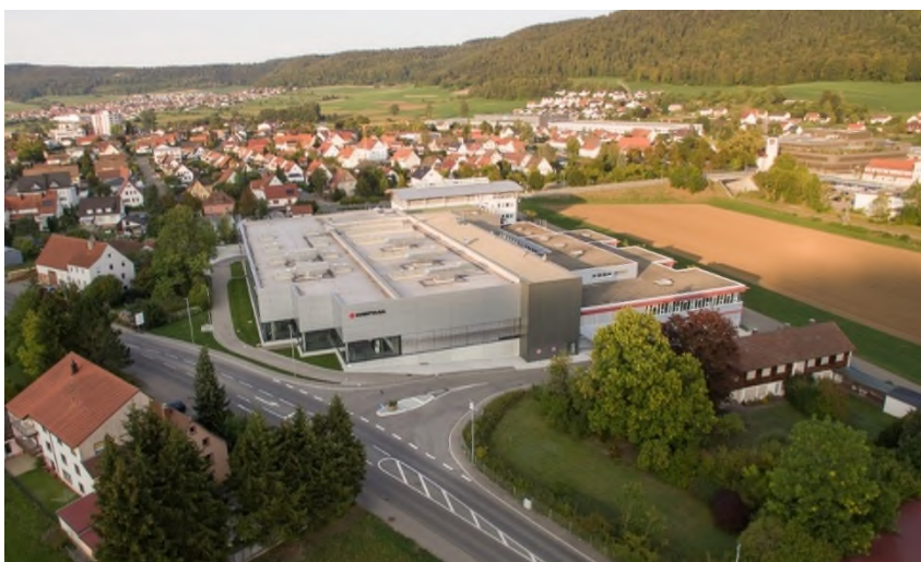
Blick von Süden auf das Betriebsgelände Fa. Werma
