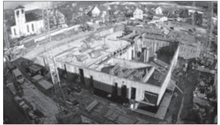
Es geht voran: Wo im Oktober noch ein leeres Baufeld zu sehen war, nimmt nun das Untergeschoss des Marquardt Entwicklungs- und Innovationszentrums Form an.
