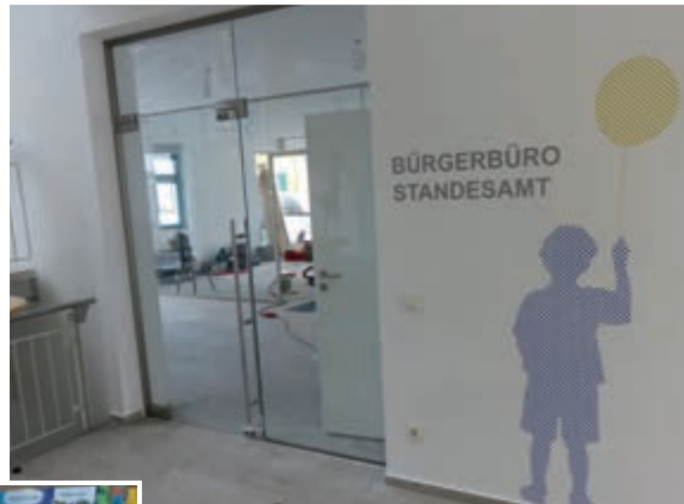
Das neue Bürgerbüro kann zum Jahresende hin ebenso noch fertiggestellt werden
