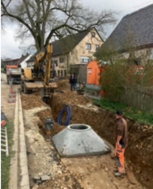
Der neue Wasserhochbehälter mit 2 Edelstahltanks zu je 30 Kubik Fassungsvermögen kurz vor der Fertigstellung.
