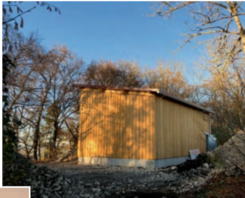
Der neue Wasserhochbehälter mit 2 Edelstahltanks zu je 30 Kubik Fassungsvermögen kurz vor der Fertigstellung.
