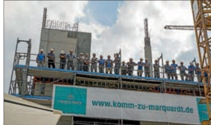
Richtspruch auf dem Marquardt Entwicklungs- und Innovationszentrum.
