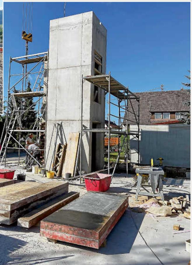
Auf den Bildern ist die fertige Bodenplatte mit dem Schachtturm für den Aufzug zu sehen. Ebenso mussten aus statischen Gründen noch zwei zusätzliche Betonelemente erstellt werden, in die auch Aussparungen für die Lüftung kamen. Aktuell wird noch die Abdichtung aufgebracht, auf der dann der Kindergarten in Holzständerbauweise durch die Zimmerei Michael Damaschke aus Mühlheim erstellt werden kann.
