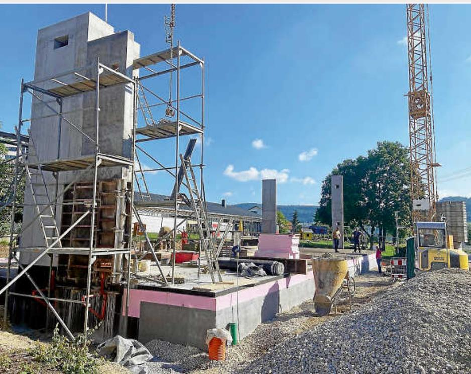
Nachdem die Rohbauarbeiten für den Anbau des Rietheimer Kindergartens durch die Wurlminger Firma Hermann Schmid inzwischen bereits weitestgehend abgeschlossen werden konnten, wird noch in dieser Woche das Gerüst erstellt, damit der weitere Aufbau in Holzständerbauweise in den kommenden 2-3 Wochen erfolgen kann. Somit kann also schon in Bälde Richtfest gefeiert werden. Damit wird also schon in Kürze die wahre Größe und das Ausmaß des neuen viergruppigen Anbaus deutlich erkennbar sein.
